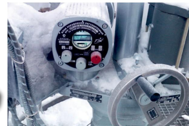
Рисунок 5 — Электропривод «РэмТЭК» на ПСП «Томскнефтепереработка»
